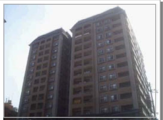
被災時築7年（1998年完成） 15階建て 居住者108世帯 270人
