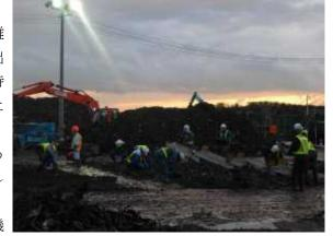
能の被害の大きい沿岸市町の処理業務を県が沿岸 12 市町から委託を受けて、ブロックごとに処理を行っているもので、亘理名取ブロックの岩沼処理区の処理状況の説明と見学をさせて頂いたものです。業務受託者は大手ゼネコンがトップに座った特定 J V でこの処理区だけでも 162 億円の契約額で、約 200 人の方が働かれていますが、手作業での分別作業にあたる人は、もっと雇用の場づくりとして活用できるのではないかと感じたところです。
