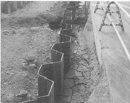
国分川の堤防耐震化工事
