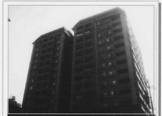
被災時築7年（1998年完成） 15階建て 居住者108世帯 270人
